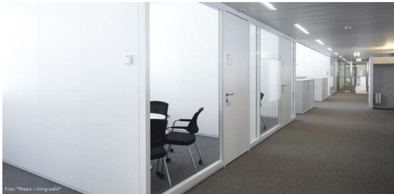
Die ebene, stilvolle Stahl-Systemtrennwand von maars bietet ein gutes Preis-Leistungsverhältnis. Die patentierte Klickverbindung ermöglicht eine schnelle Montage und einzigartige Flexibilität. In Kombination mit maars XL Stahl- und Glastüren sorgt diese Stahltrennwand für eine klare Ausstrahlung. Ganz nach Wunsch!
